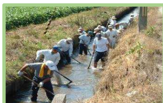
水路の泥上げ
