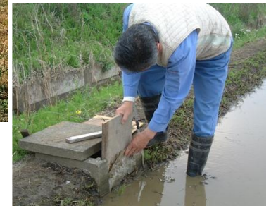
看板と止め板設置の様子
