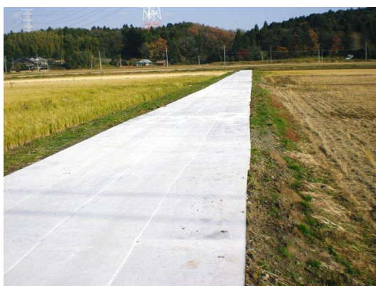
舗装の完成した農道
