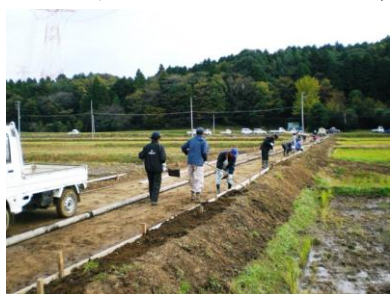
施工の様子その1
