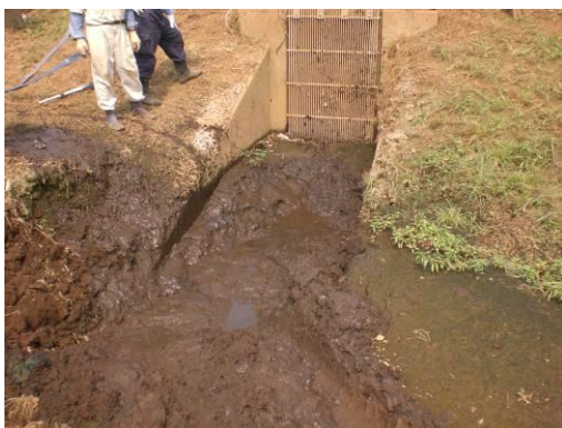
ゲート前に土砂が堆積すると排水ができなくなるため毎年の泥上げは必須
